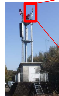
警報局全景写真
