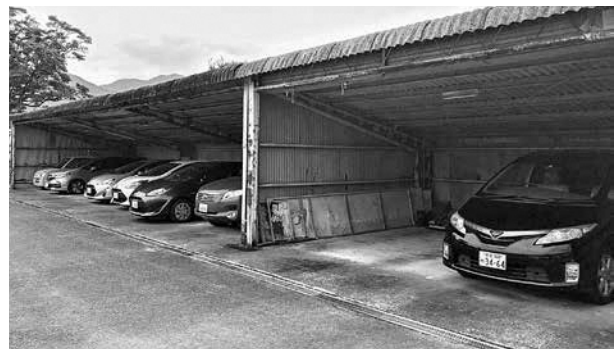
公用車駐車場(手前が長年使用した町長車)
