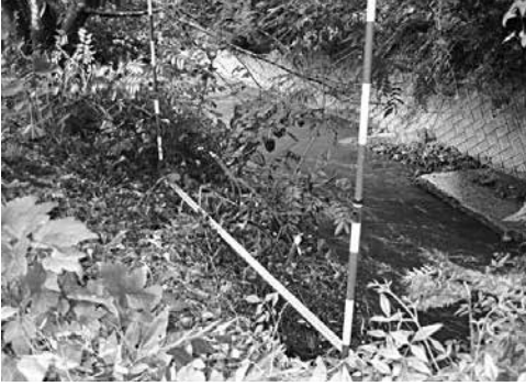
③ 都川護岸ブロック災害…中猪 ※河川
