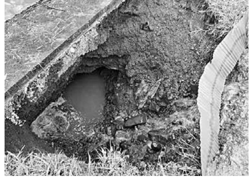
② 都川護岸ブロック災害…浅鹿野 ※河川
