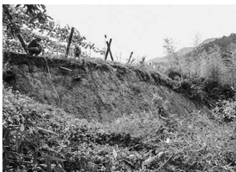
⑥ 潮山（法面崩壊） ※農地
