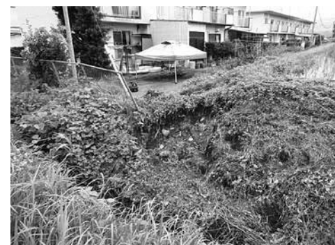
⑦ 下高見（法面崩壊） ※農業 用排水路
