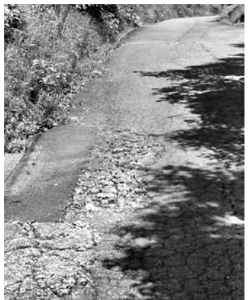
舗装面がひび割れた町道
