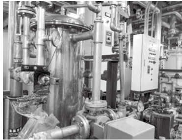
経年劣化で緊急対応を要する 温泉機械
