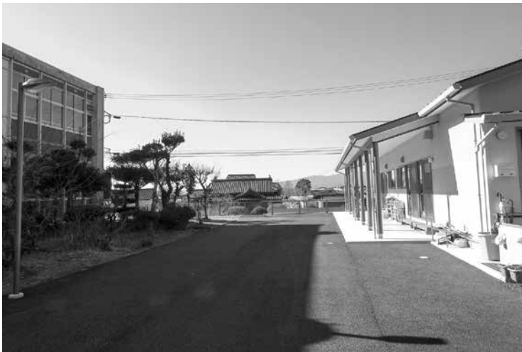
校舎と学童クラブの間にユニットハウスを増設
