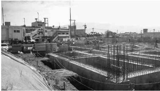
基礎工事中の上球磨消防署
