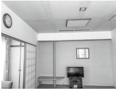
空調故障の客室と 経年劣化の蛍光灯
