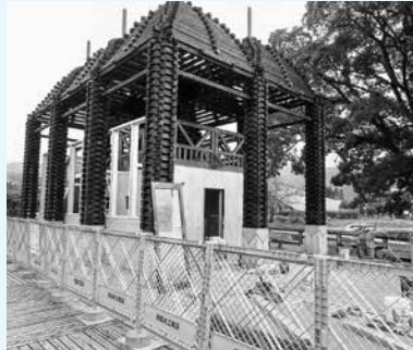
モニュメントに覆われたトイレ（建設中の写真）
