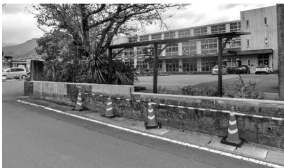
高い部分を撤去したブロック塀
