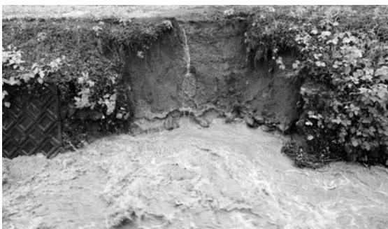
大谷川排水路の土砂崩れ
