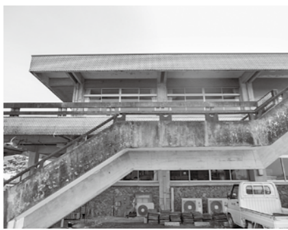
耐震補強する役場庁舎
