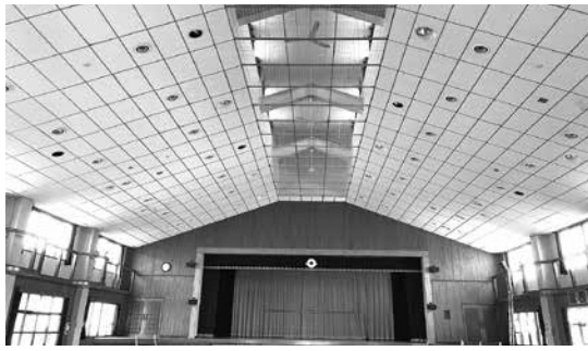
平成3年度建築の改善センター
