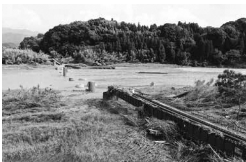
くま川鉄道・第4橋梁
