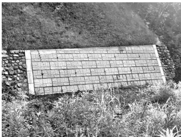
完了した町道蓑谷線の災害復旧工事
