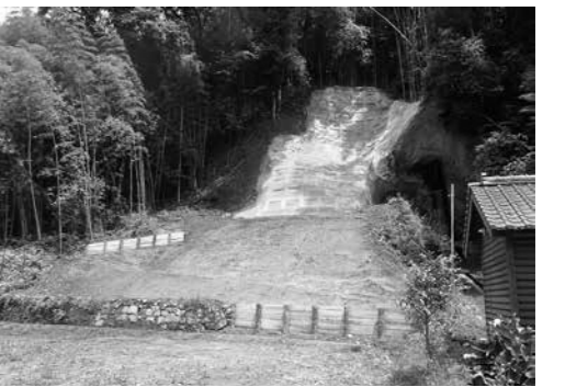
永岡地区(復旧工事後)
