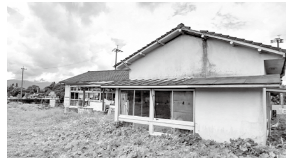
解体後は駐車場に計画されている旧南部保育所
