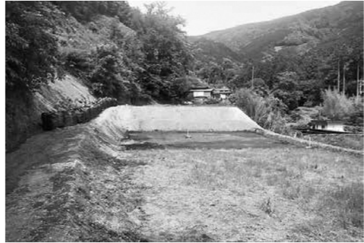
猪鹿倉山農地(復旧工事後)
