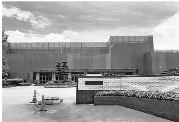
改修工事が始まった小学校
