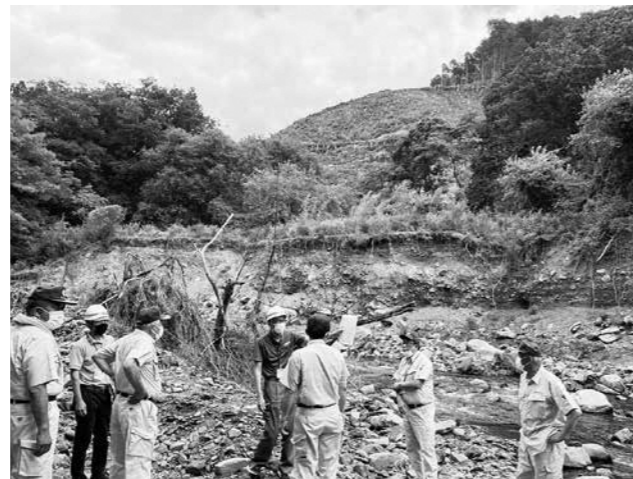
蓑谷川の被災箇所
