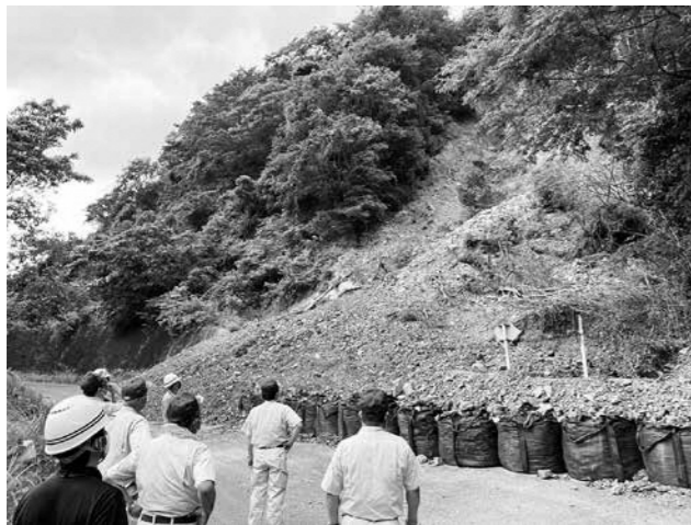
猪鹿倉横谷線の被災箇所
