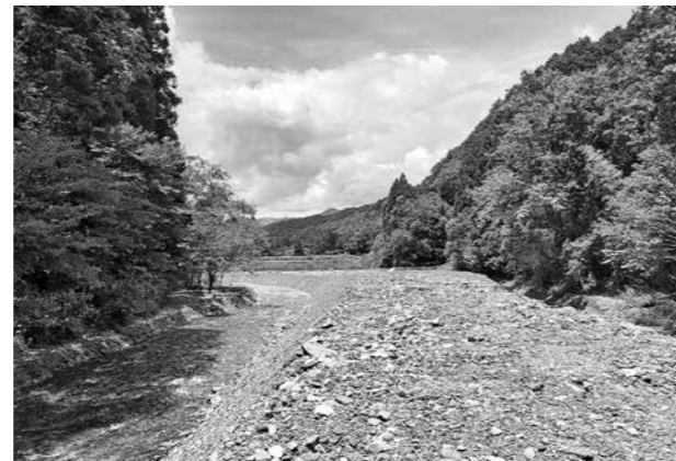
蓑谷ため池災害復旧工事
