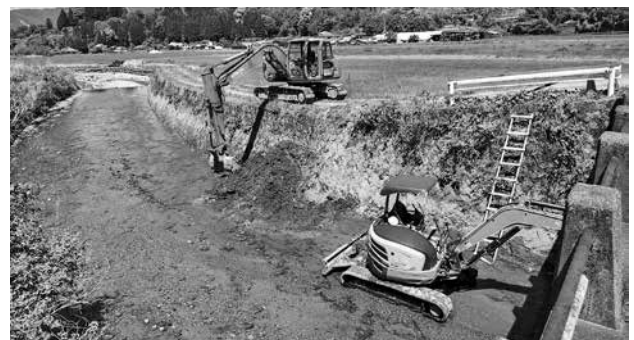
牧良川の土砂上げ工事
