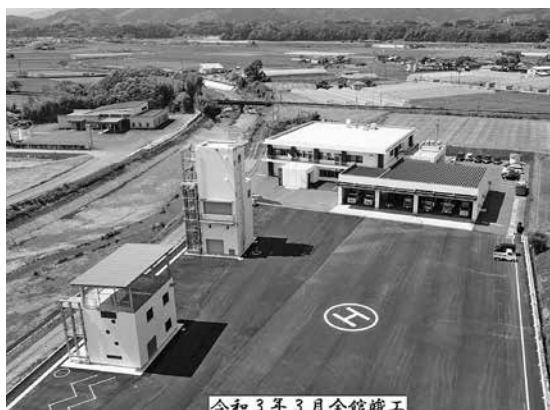
完成した地域防災の拠点施設
