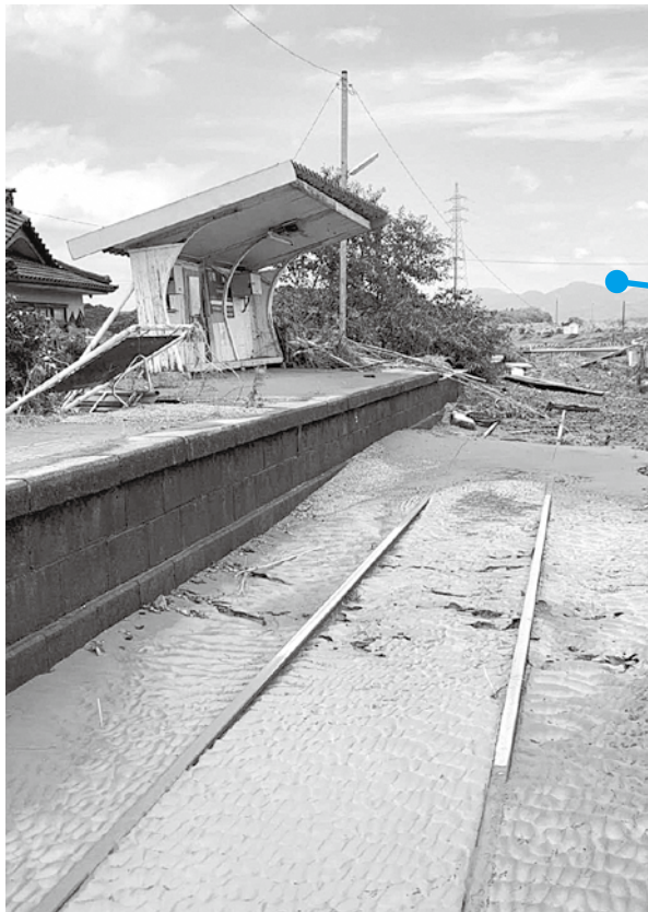
③壊れた川村駅
