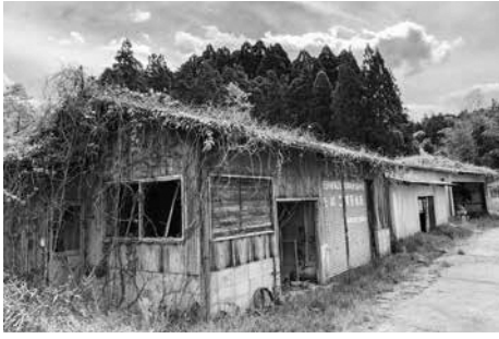
改築される倉庫
