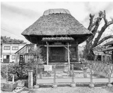
着工した御大師堂
