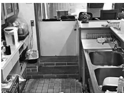
段差がありバリアフリー化が必要な給湯エリア
