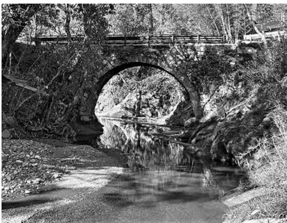
明治39年竣工以来の大規模補修となる下町橋
