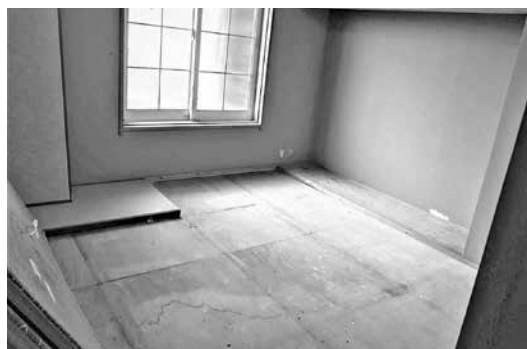
旧南部保育所の未活用スペース
