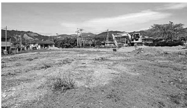
工事が始まった駅前団地
