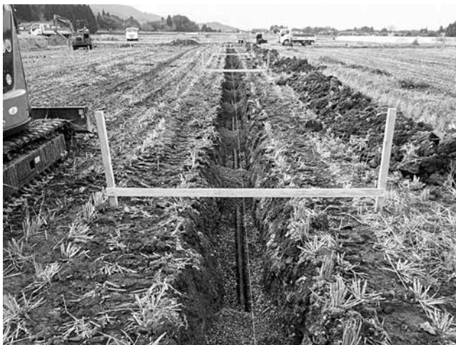
水田排水対策の工事
