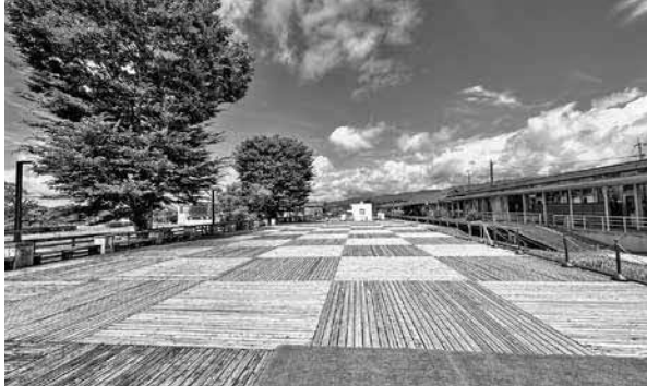
改修前のレールウイング複合施設
