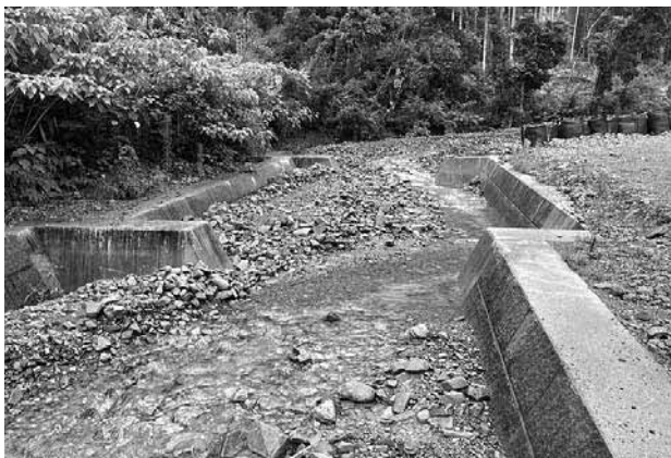
沈砂池が埋没した浅巻谷川
