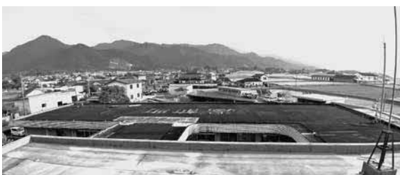
防水工事を行う庁舎屋根
