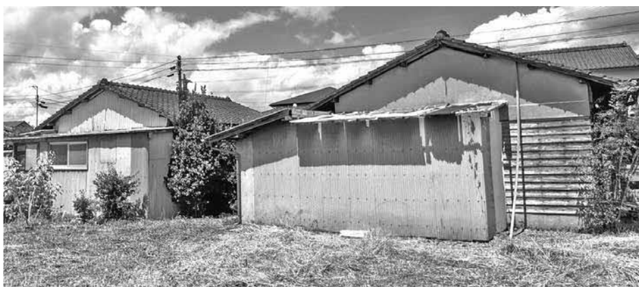
解体する上牧原住宅2棟
