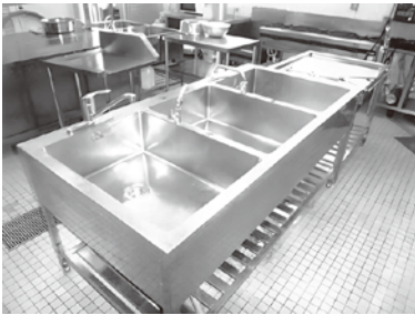
築35年が経過した調理室
