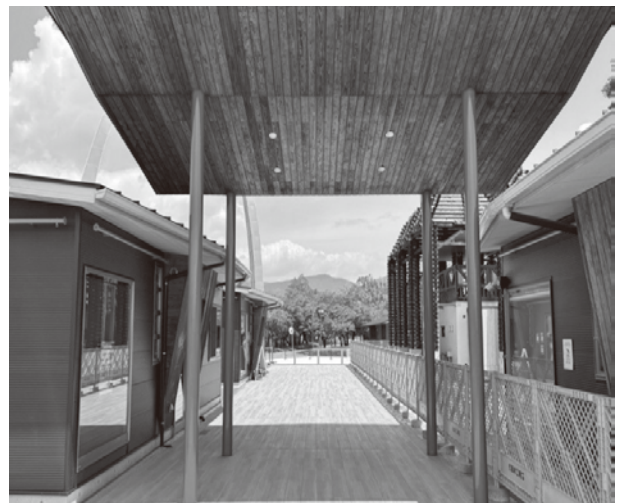
大屋根新設部までの東側床改修工事完了
