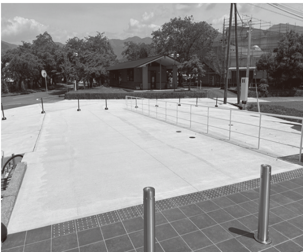
東側スロープ工事完了
