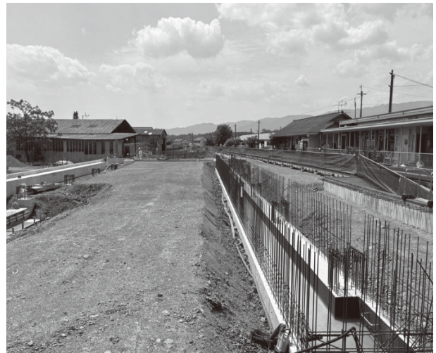
西側付属棟新設部基礎工事施工中
