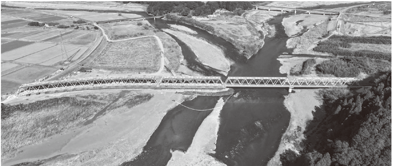
全国でも珍しい曲線を描くトラス式橋梁
