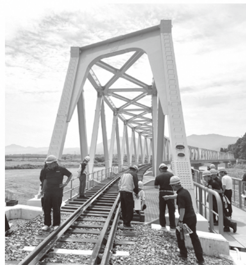
球磨川第四橋梁の復旧状況を現地で確認
