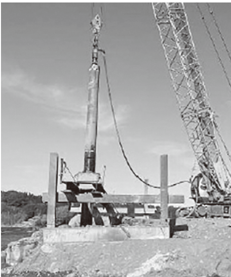
硬い岩盤の掘削状況
