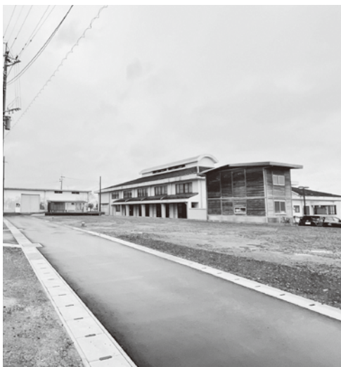
造成工事が進む分譲地
