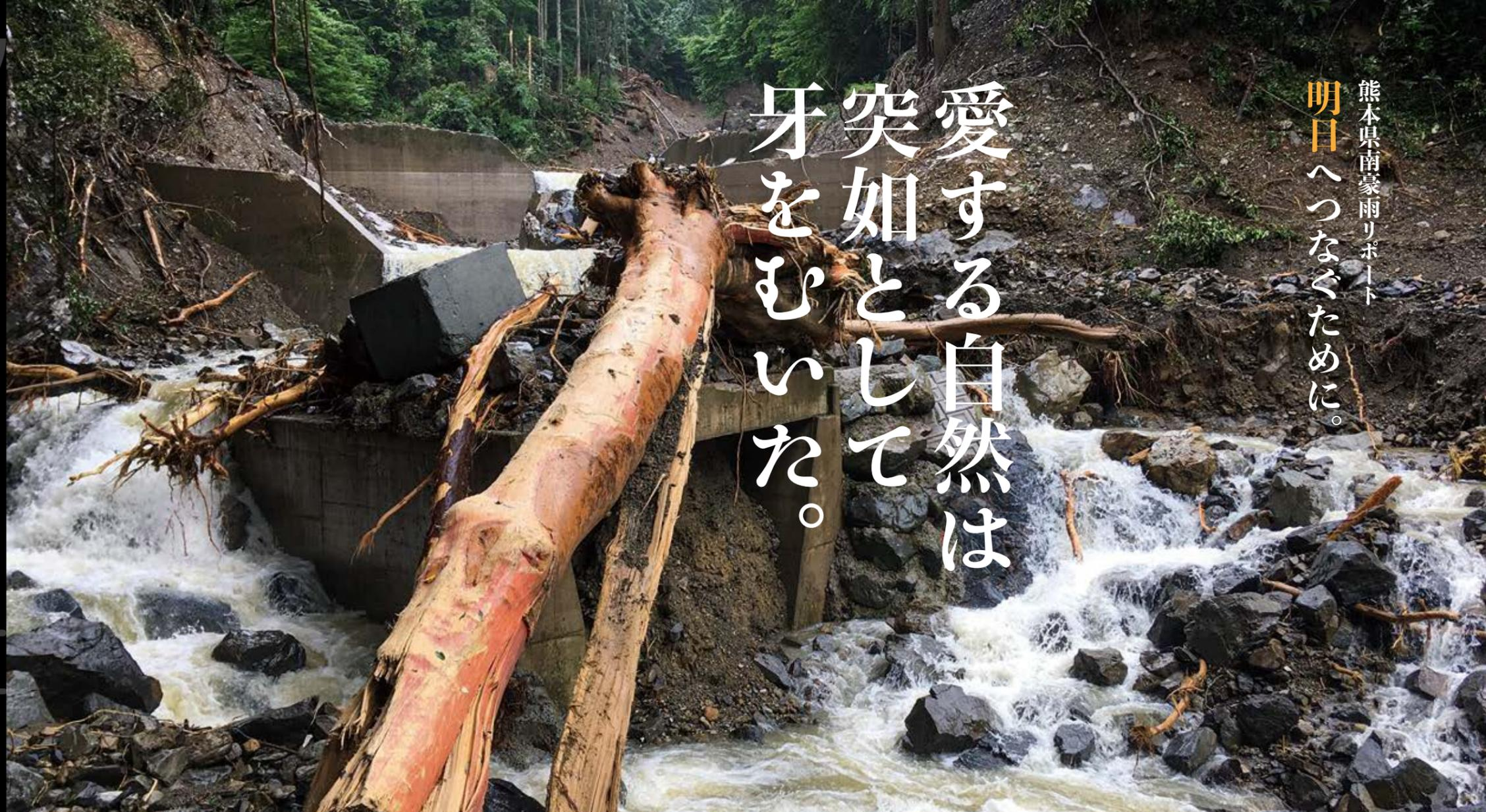
山腹の崩壊で土砂と流木が発生。中央の橋の崩壊から伝わる水の恐怖
