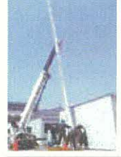
電柱の建て替え
