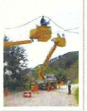
通信ケーブルの張り替え
