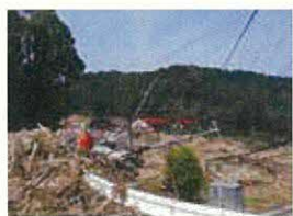
電柱の倒壊・管路の損壊
