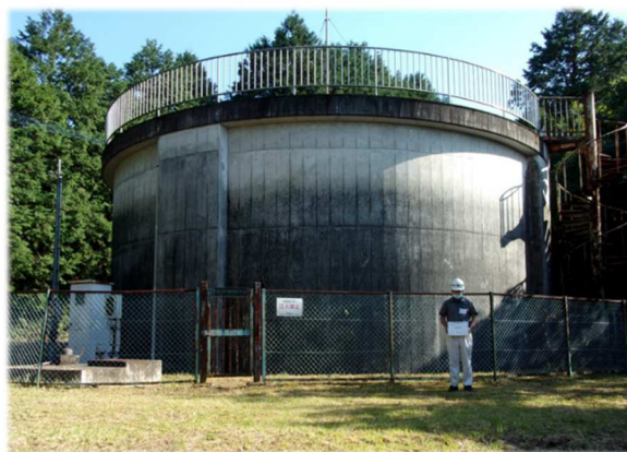
配水池全景（低区配水池）
