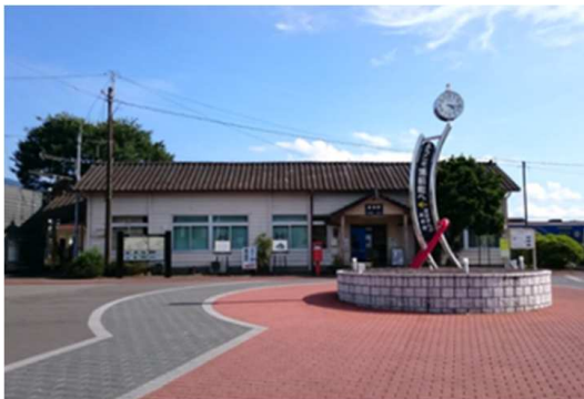
くまがわ鉄道湯前駅本屋(駅舎入り口周辺)
