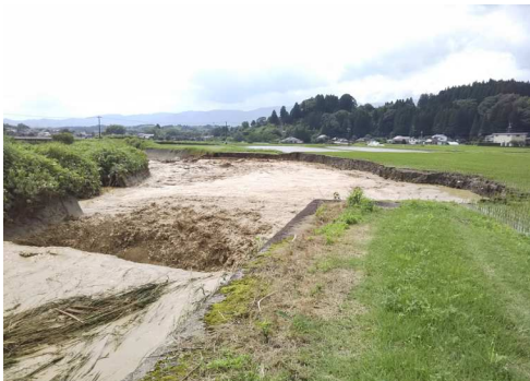
重点区域内の災害状況(河川)
