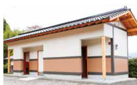
汲取式トイレから水洗トイレに
