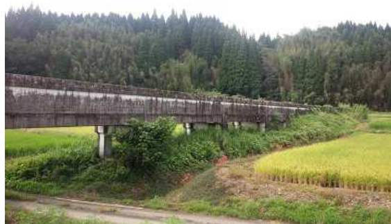
牧良川水路橋（側面）
