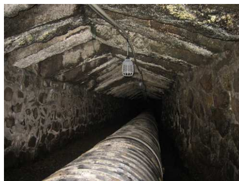
水路（旧貫）内部
