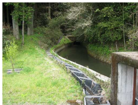
古城隧道（新貫）出口
