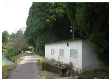
仁原ポンプ揚水場
