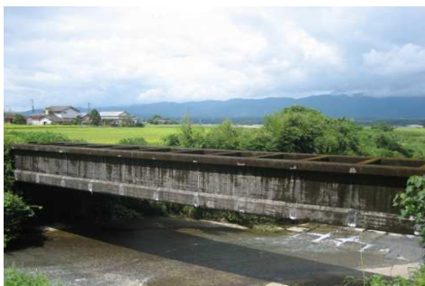
仁原川水路橋（全長 35m）
