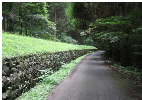
幸野溝導水管部分
