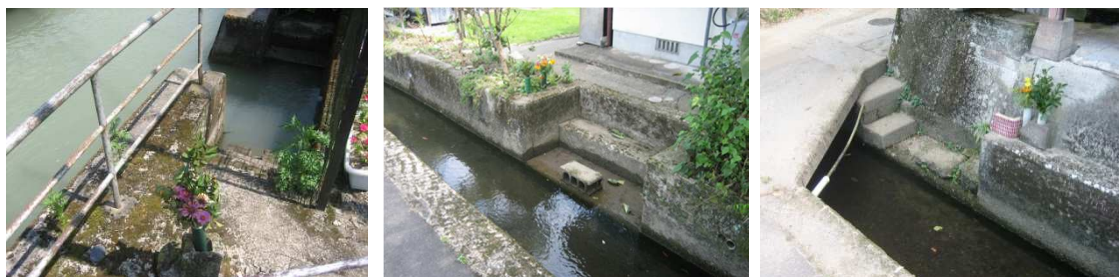
町内の水路でみられる供花等の状況
