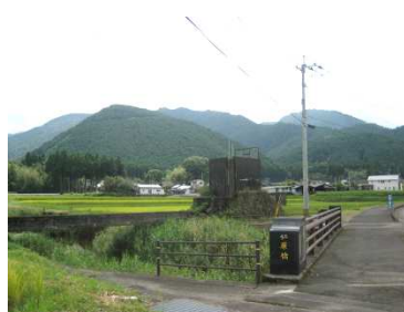
仁原揚水分水塔
