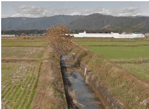
柳田放水路（上村区）
