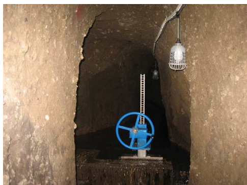
旧貫との接続部分
