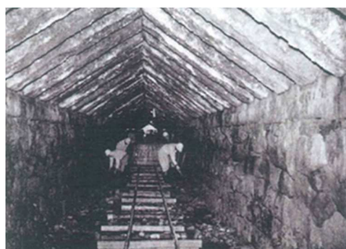
古城隧道（昭和の大改修時）
