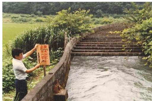
水路橋の安全点検
