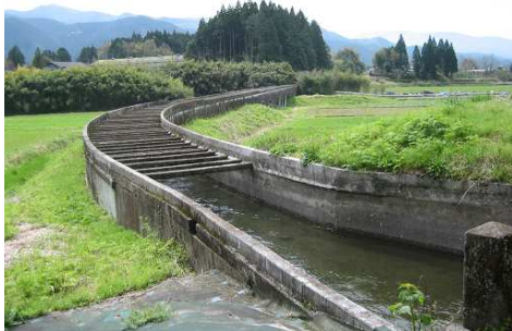
牧良川水路橋（全長 147m）上部
