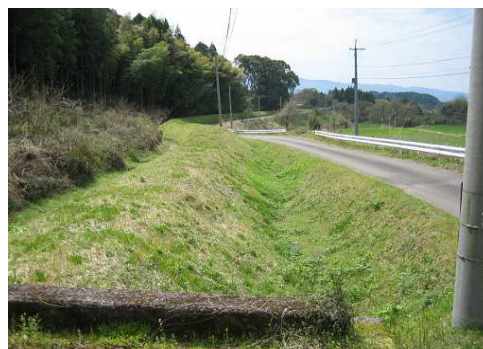
幸野溝導水管部分
