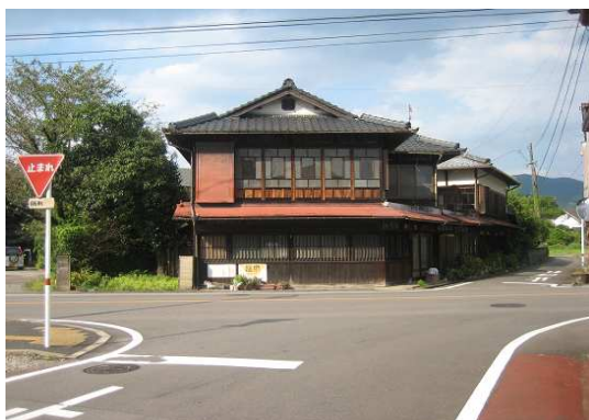
国道沿いに残る明治期の建造物
