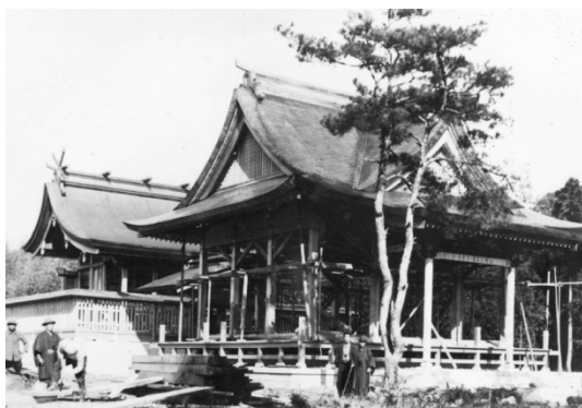
建設中の市房山神宮里宮神社
