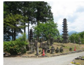
九重石塔（修理後）
