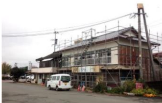
駅前旧旅館の修理
