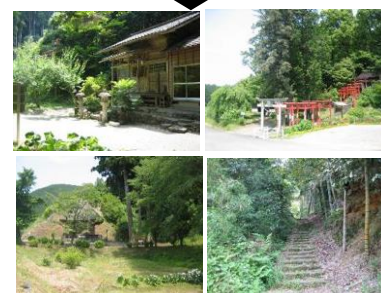
建造物の維持管理状況 H30
