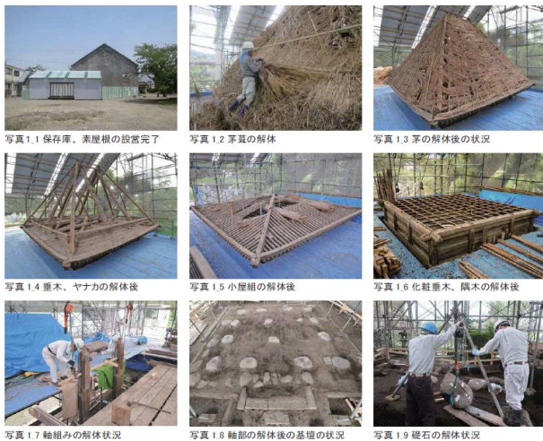
下里御大師堂保存修理工事の進捗状況
