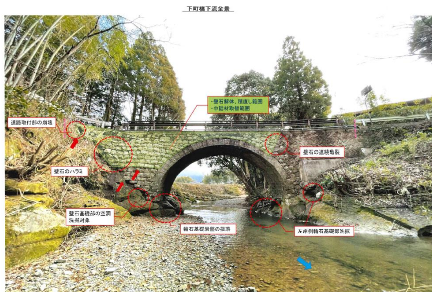
補修設計に伴う詳細調査写真
