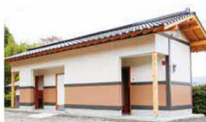
汲取式トイレから水洗トイレに
