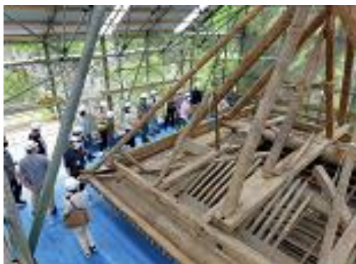
修理工事見学会の状況
