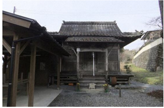
写真 3-29 湯前城跡に建つ普門寺観音堂
