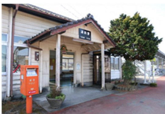
写真 3-35 現在の湯前駅本屋
