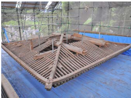
4) 野地解体後の垂木
