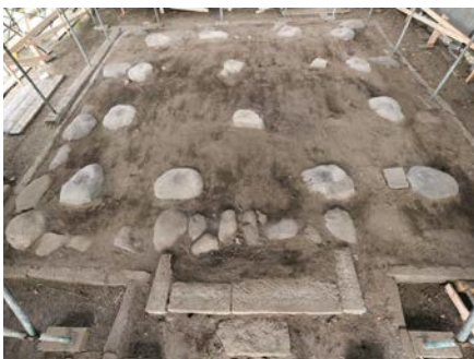
7) 軸組解体後の基壇
