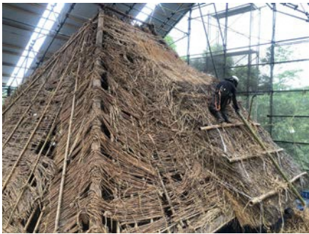
1) 屋根の解体作業状況
