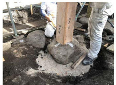
9) 礎石の据え直し作業状況
