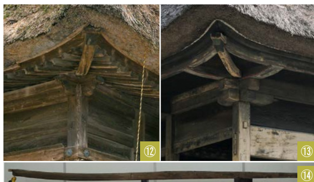
写真⑫_御大師堂の軒裏 角柱と化粧垂木
