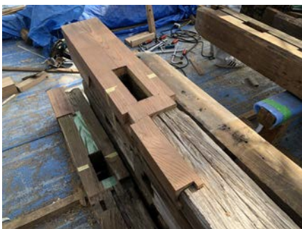
10) 柱の根継の状況
