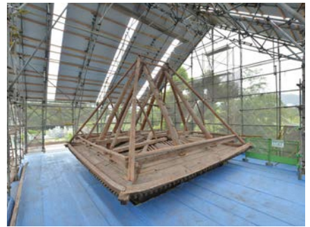
3) 垂木解体後の扱首（さす）組
