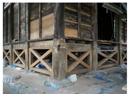
15) 耐震補強工事の状況
