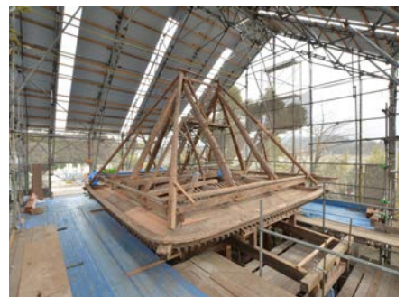
12) 軸組、小屋組の組立完了状
