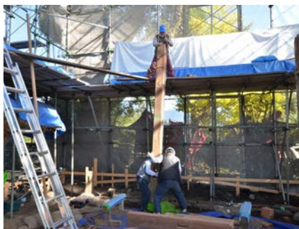
11) 軸組の組立作業状況
