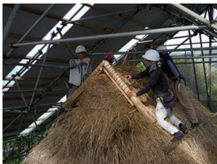
・棟飾の取付け。
