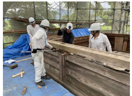
6) 軸組の解体作業状況
