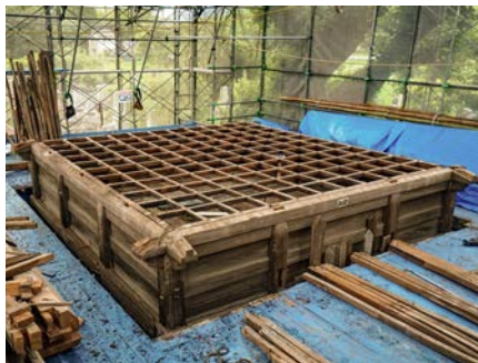
5) 小屋組解体後の軸組
