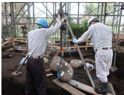
8) 基礎石の解体作業状況
