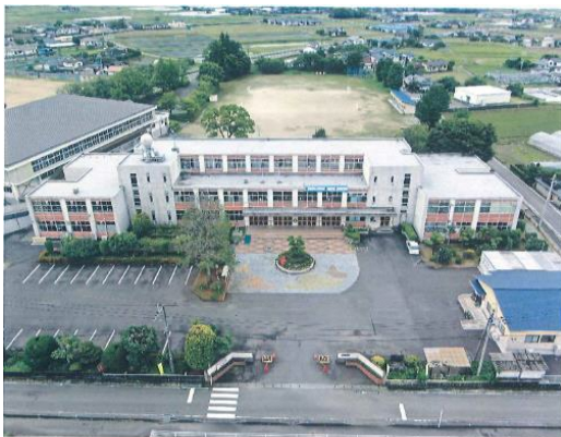
着工前 北面全景
