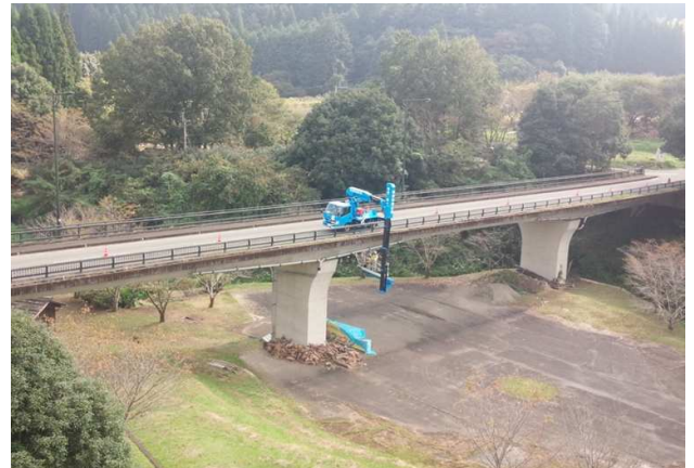
潮大橋(PC ポステン中空床版橋)
