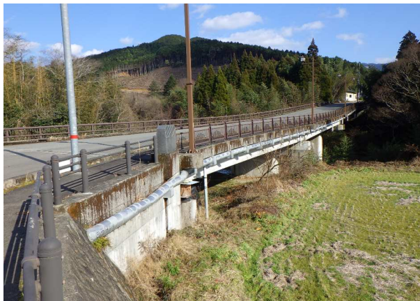
原ノ淵橋(PCT 桁橋)
