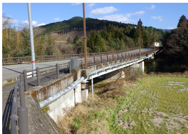
原ノ湍橋(PCT 桁橋)
