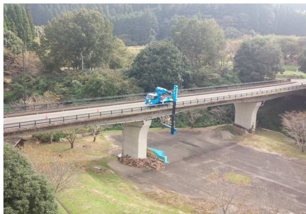
潮大橋(PC ポステン中空床版橋)
