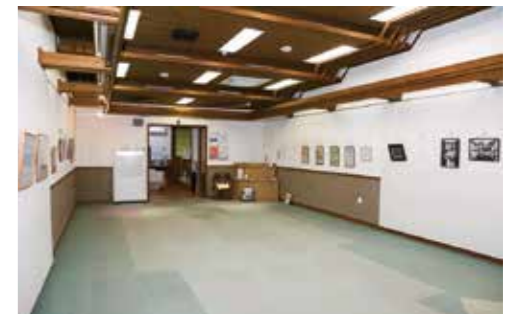
工事の準備が進められる展示室
