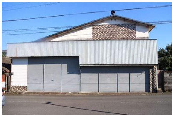
空き家バンク登録物件（店舗付き住宅）
