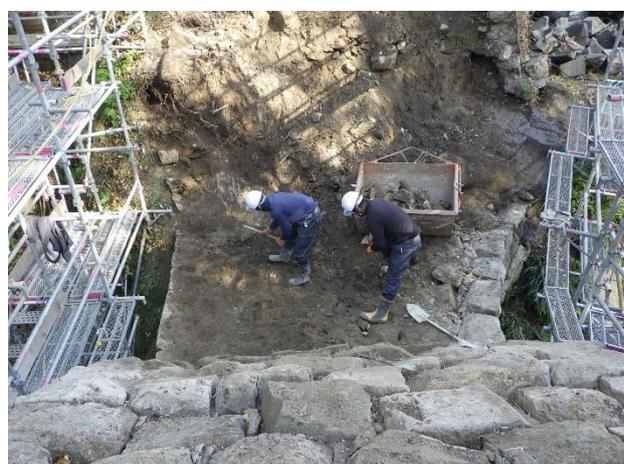
・下町橋損傷部（壁石）解体後
