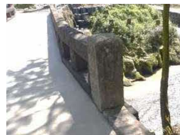
補修後の状態
