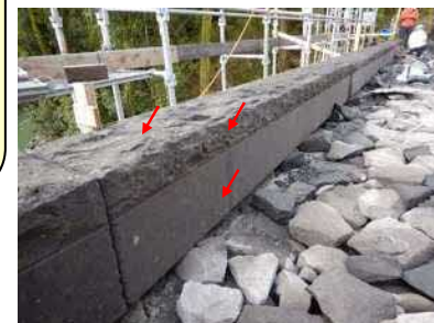
地覆石の表面仕上げ 天 端（割肌仕上げ） 側面上部（割肌仕上げ） 側面下部（切削仕上げ）：舗装工部
