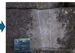
写真-6 輪石欠損部②の修復状態(現況→補修後)
