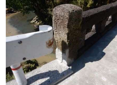
補修後の状態
