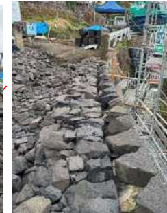
壁石天端高調整(上流側)
