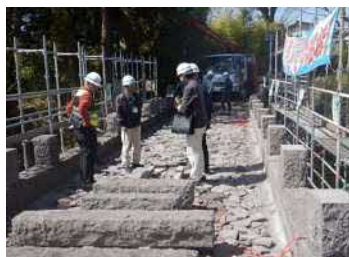
束柱の設置確認状況
