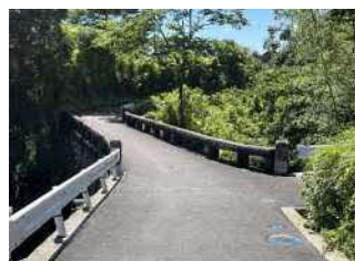
終点側(右岸側)
