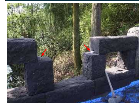
束柱・笠石接続部拡大
