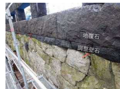
下流側の地覆石と調整壁石の完成状況
