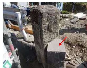
法線変形部の端部束柱の形状調整
