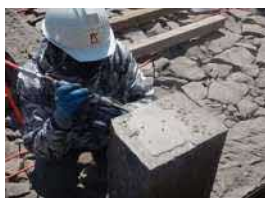
加工作業2:束柱天端高を調整 (ハツリ仕上げ)
