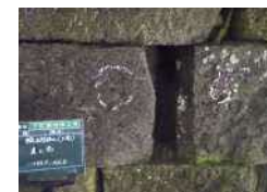
写真-6 輪石欠損部②の修復状態(現況→補修後)
