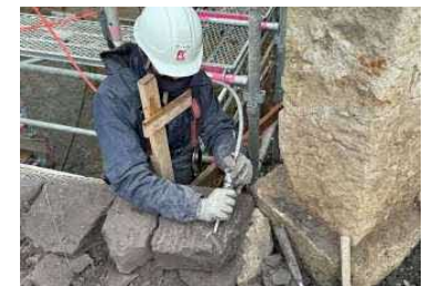
壁石調整工(天端加工調整)
