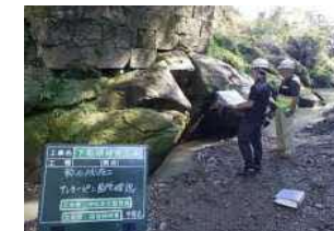
アンカーピン位置確認状況
