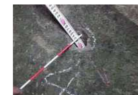
④ 施工箇所
