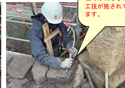
壁石と地覆石との接合部は、滑り止めとしてビシャン仕上げ程度の加工が施されている
