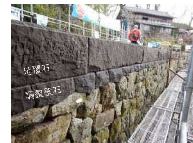
上流側の地覆石と調整壁石の完成状況
