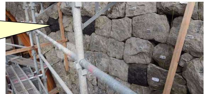
長尺締石の設置状況
