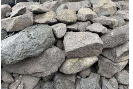
中詰め材の緻密な仕上げ状況 (立体三次元積み仕上げ)
