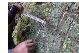
⑦ 施工箇所
