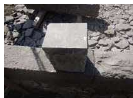
加工作業1:束柱製品の天端 (材の状態:切削仕上げ)
