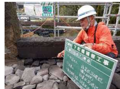
ステンレスアンカーボルトの確認状況
