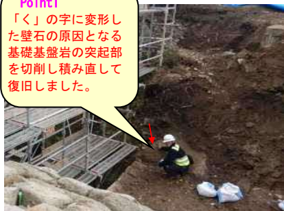
傾斜のある基岩箇所を確認
