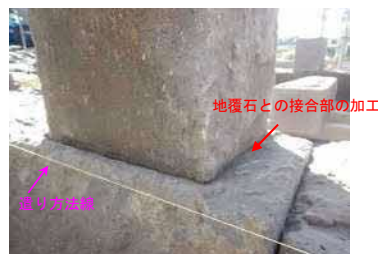
地覆石(溝切り)と束柱の設置状況
