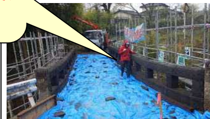
マーキング作業状況
