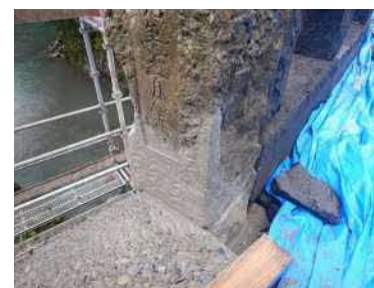
写真-5 親柱Bの欠損部修復状態
