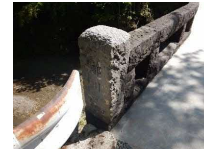
補修後の状態
