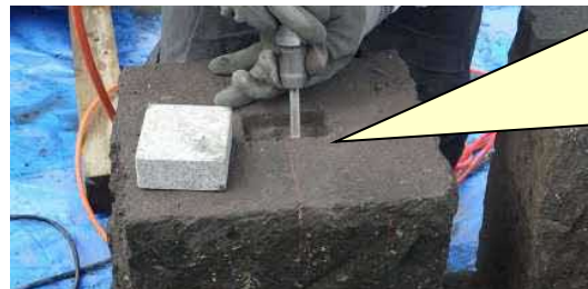
高欄:笠石・束柱接続部の光づけ(ダボ石設置)作業状況
