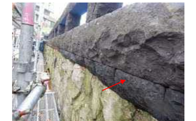
壁石調整工の仕上がり状況
