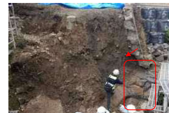
湧水箇所及び既存根石状況確認
