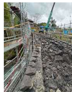
壁石天端高調整(下流側)
