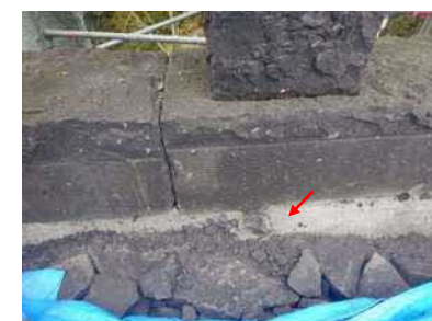
地覆石と壁石調整工との間をモルタル充填
