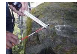
⑥ 施工箇所
