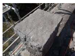
加工作業3:天端高調整完了 (ハツリ仕上げ)
