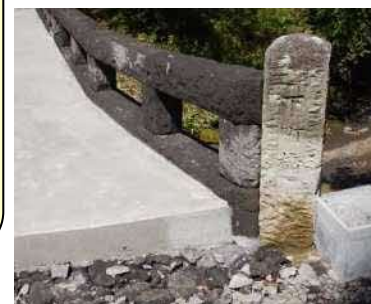
補修後の状態
