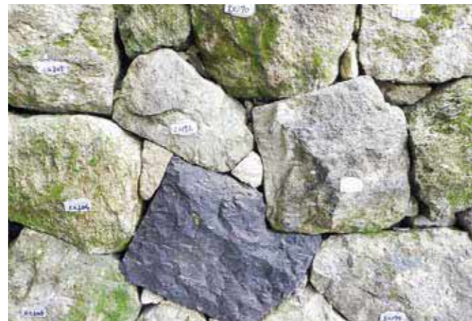
壁石取替前(右)と取替後(下)
