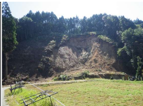
② 後山 山腹工着工前
