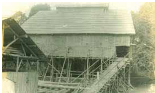
修理のために素屋根が掛けられた阿弥陀堂
