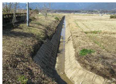
排水路浚せつ 溝合集落（上村区）
