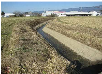
排水路浚せつ 上里集落（上里地区）
