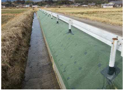
防草シート敷設 中部集落（上里三）
