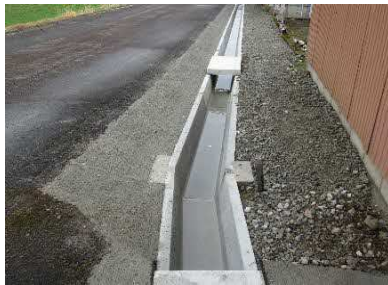
用水路改修 永野集落（馬場区）
