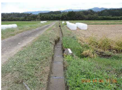
用水路目地補修 松下集落（植木）
