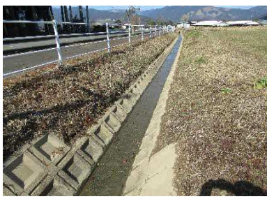
排水路浚せつ 深田集落（上村区）
