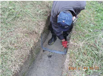
用水路目地補修 松下集落（植木）
