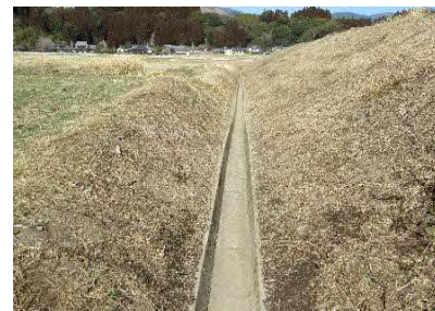
排水路浚せつ 上染田・蔵ノ本集落
