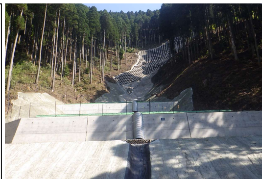
⑦小迫 山腹工完成後
