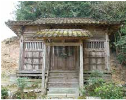
修理前の八勝寺阿弥陀堂
