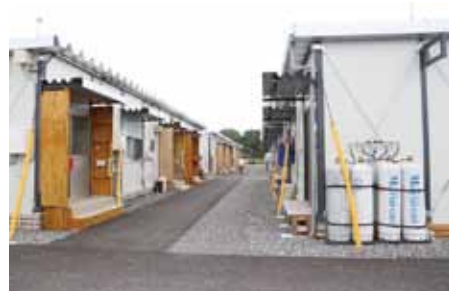
熊本地震で建てられた仮設住宅は4000戸以上。阿蘇くまもと空港近くのテクノ団地には516棟が建ち、家を失った人たちが元の生活を取り戻すために力を合わせて生活している
