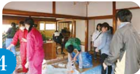
空き家をみずから手で改修する参加者
