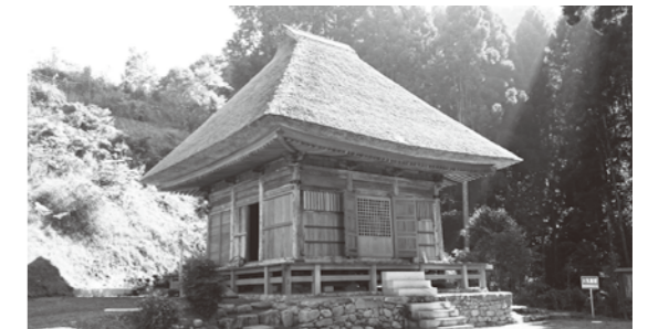
平成27年に修復され、元のかやぶき屋根の姿を取り戻した阿弥陀堂
