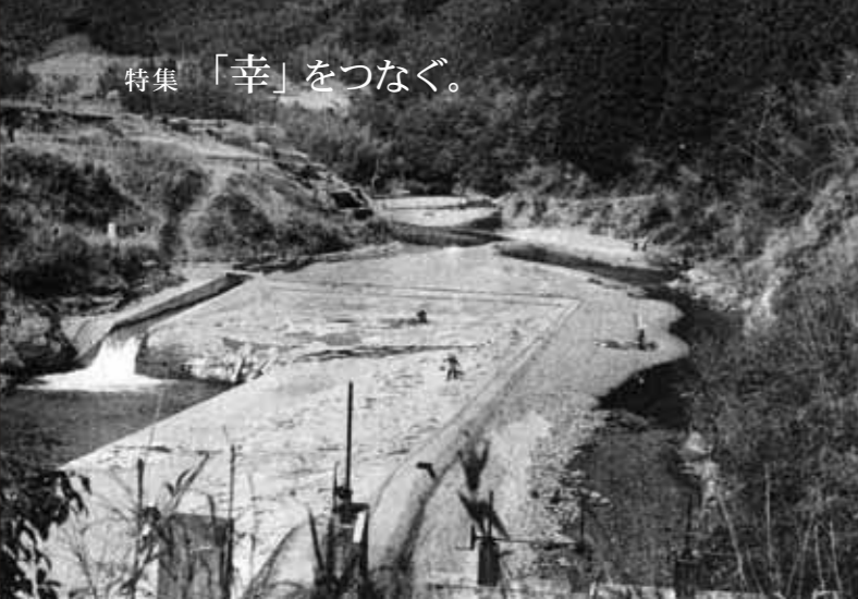
浜川の水戸神社付近から見た昔の取水口。水の流れをせき止め、調整していて、江戸時代から昭和33年まで約250年間使われていた。左側には木材を運び出すための「いかに流し」があった
