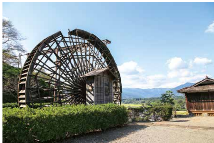
解体工事が始まる親子水車。老朽化で3年前に動きを止めていた
