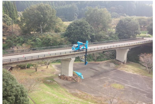
潮大橋(PC ポステン中空床版橋)
