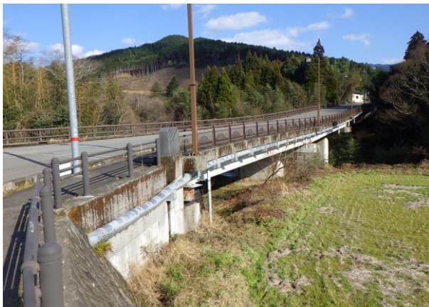
原ノ湫橋(PCT 桁橋)
